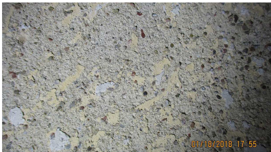
Foto 15 Częściowa odkrywka w celu ustalenia pierwotnego koloru
