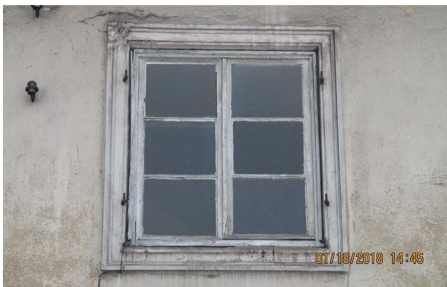
Foto 6 Przykładowe zdobienia w formie opaski okiennej oraz stara drewniana stolarka okienna
