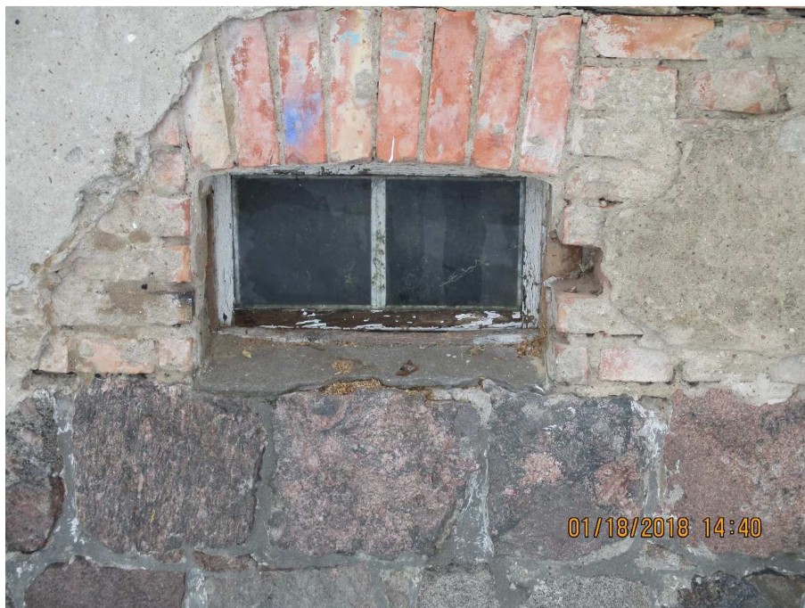
Foto 8 Stara drewniana stolarka okienna w części piwnicznej
