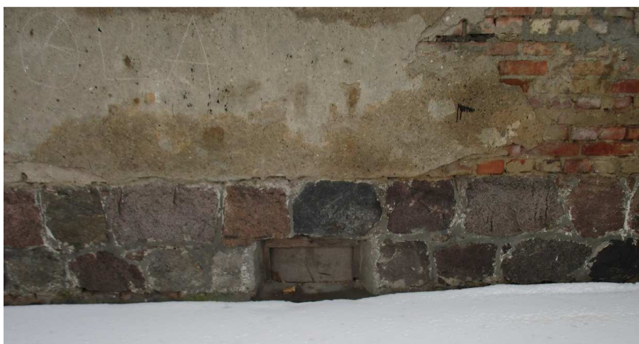
Foto 9 Fragment cokołu wykonanego z kamienia polnego łupanego
