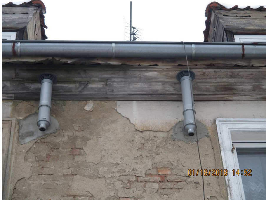
Foto 14 Wywiewki wentylacyjne na elewacji oraz fragment drewnianego gzymsu
